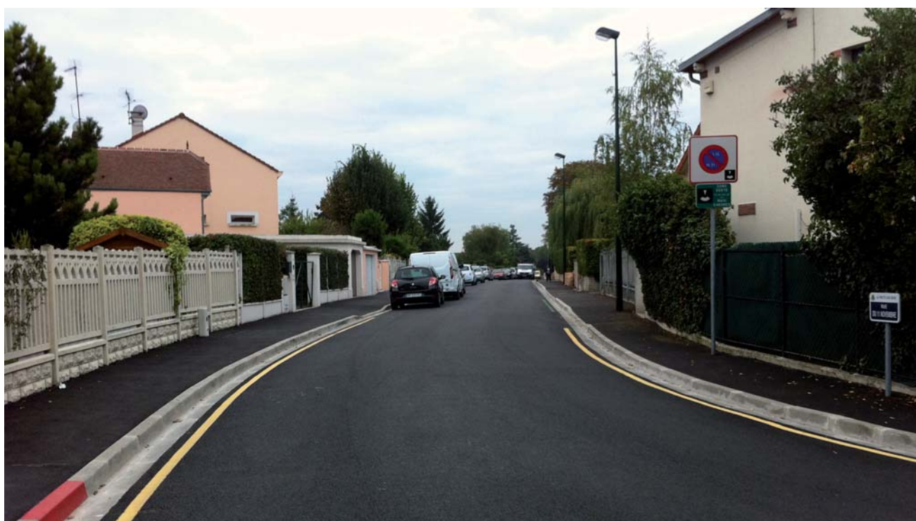
La rue du 11 Novembre a été rénovée cet été.
