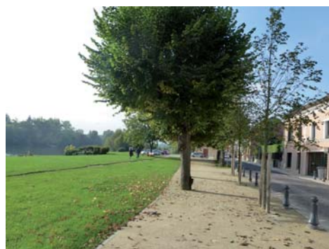
Travaux de «L'ESPACE IDENTITAIRE».
